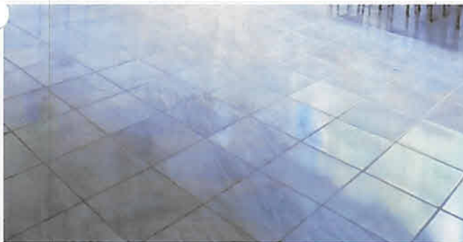
Foto 5: Finalización instalación de piso.
