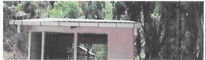
Foto 2: Finalización colocación de canales
