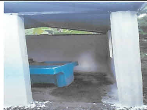
Foto 4: Finalización reparación de Cocina
