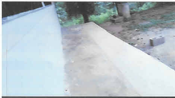
Foto 3: Finalización ampliación de acera.
